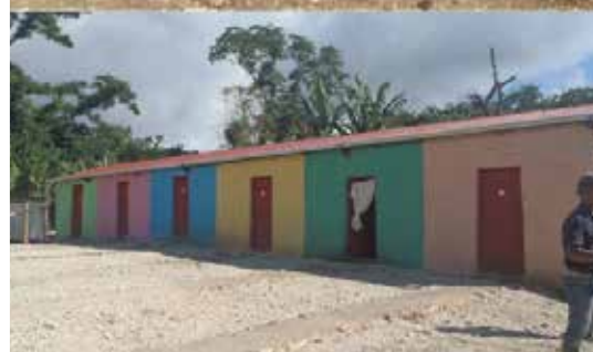
Després de la reforma
