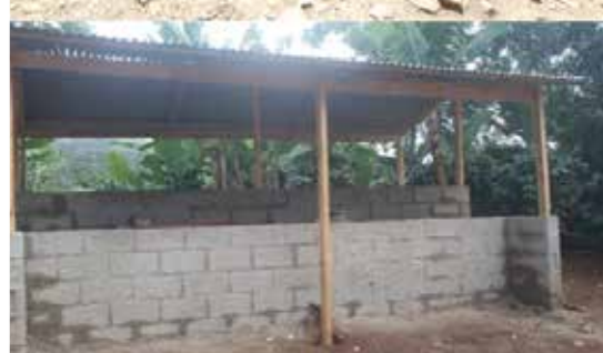
Cuines després de la reforma
